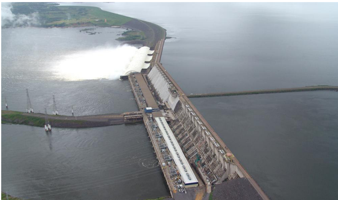
Figura 1 - Usina Hidrelétrica de Tucuruí-PA
